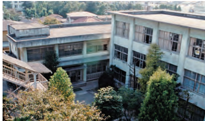
南館 左が図書館棟
