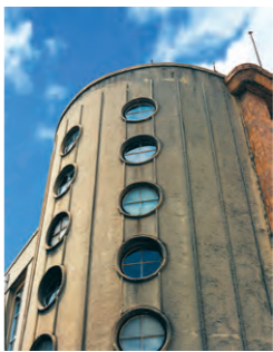
円筒形の壁面と丸窓
